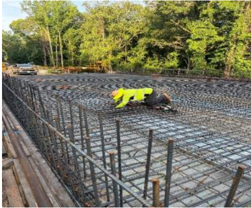
Checking Drain before concrete pour
