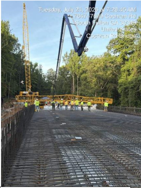
Bent 3 deck pour start
