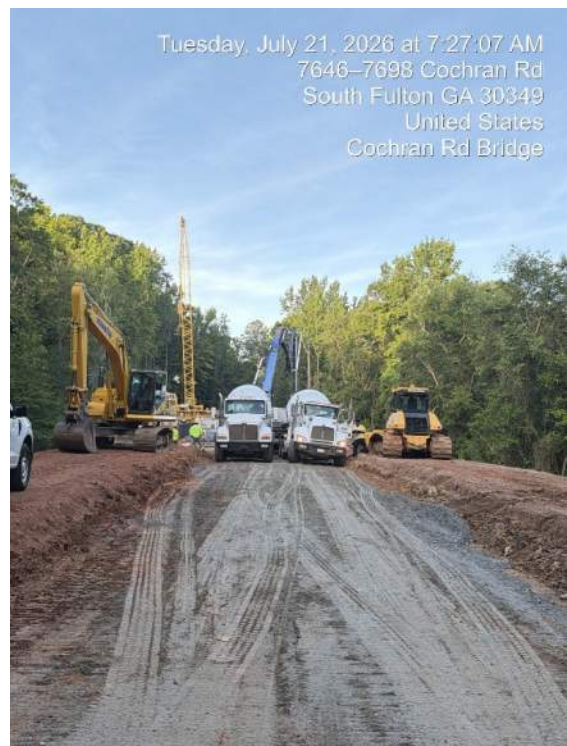
Deck pour on Bent 3 side
