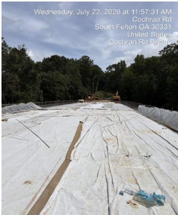
Bridge deck pour complete
