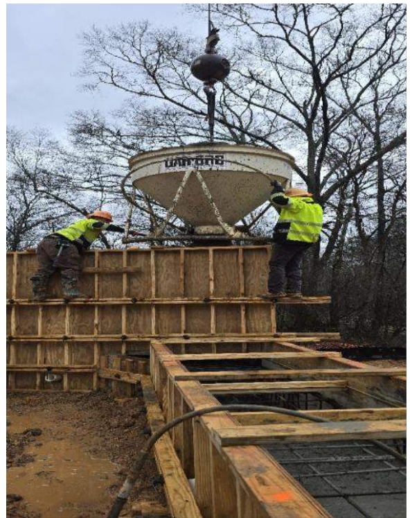
Loading cement for cap pour at Bent 3
