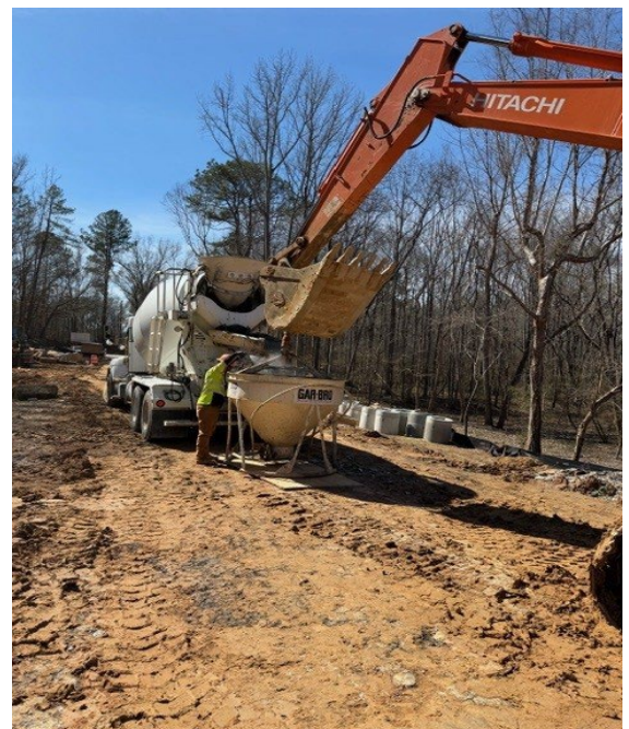
Loading cement for cap pour at Bent 1
